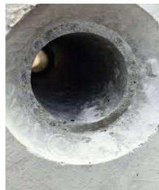
Rivepipe est une solution innovante pour les structures de coffrage, spécialement conçue pour protéger les tirants lorsqu'ils sont insérés pour former le mur, et pour créer une traversée de mur en béton propre et vide. Il peut être extrait rapidement et facilement (en 5 secondes environ) et sans endommager le mur. Le résultat est un trou circulaire propre,
